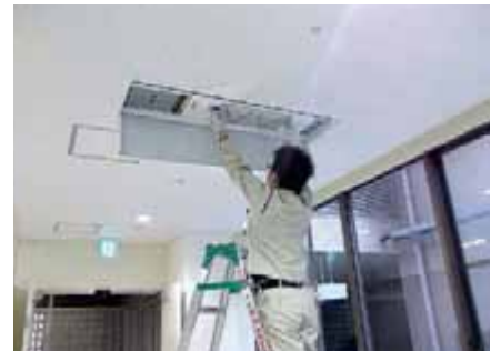
ファンコイル設備 フィルター交換業務
